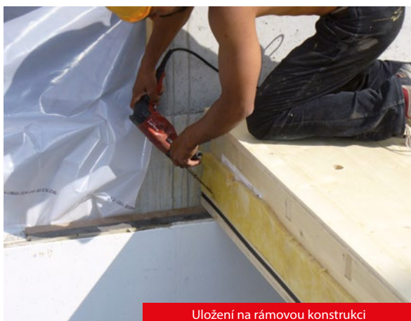
Uložení na rámovou konstrukci
