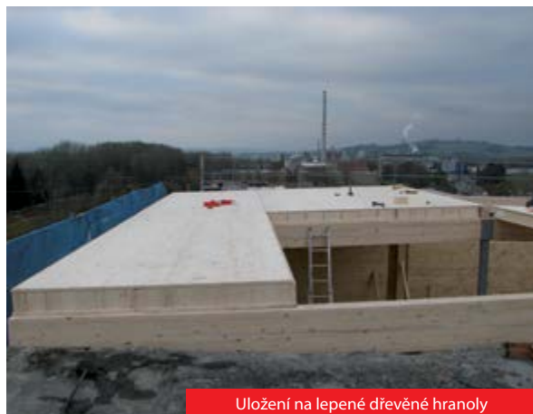
Uložení na betonový věnec a lepený hranol
