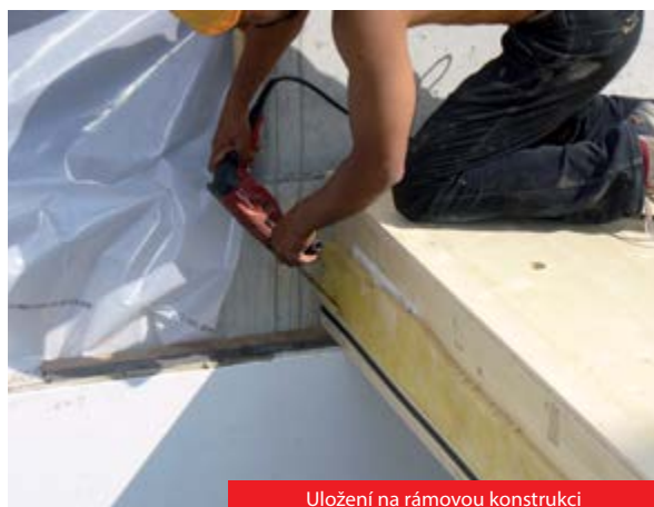
Uložení na rámovou konstrukci
