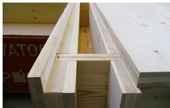
Uzavření pohledového výřezu masivní deskou.
