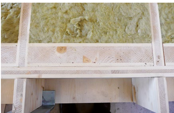
Zesílení masivním dřevem v místě tlaku.
