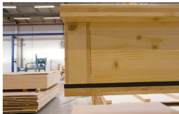
Montáž protipožární pásky v podélném spoji.
