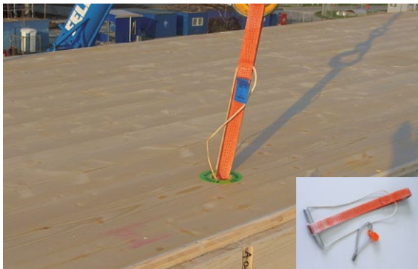
Závěsné třmeny (4 ks pro jeden ELEMENT).
