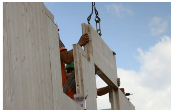
Příprava spoje a osazení – SOLID 84, 124 mm.
