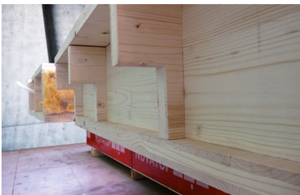
Opracování osazení – jednostupňové.
