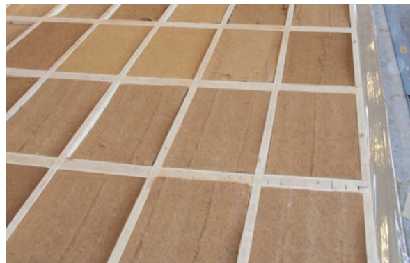
Vyplnění dřevovláknitou izolací.
