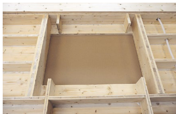
Zesílení masivním dřevem v místě tlaku.
